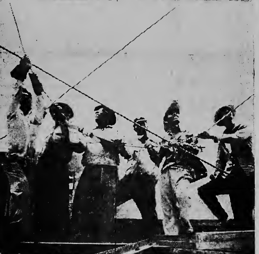
Bao di controle di senior C. Kollard, contrastista di Bouw Maatschappij Aruba N.V., nan a hisa ayera e prome spant pa dak di e teatro. E biga di herro aki cu ta midl 16 meter largu, y esun di mas chiki den e enateran cu mester worde pone ta pisa mas o menos un ton y mei y no tabata tin cos chiki pa hanja e spant aki na su lugar. E spant numero cuater cu ta 24 meter largu lo pisa casi dos ton y mei. E portre ta duna un idea cu e trabao ta marcha.
